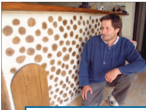
Eric Julien est passé de la teinture industrielle des textiles à la bioconstruction sous statut d'artisan. Chez lui, à Tauxigny : colombage avec enduit à la terre pour le salon et bois cordé pour la cuisine.
